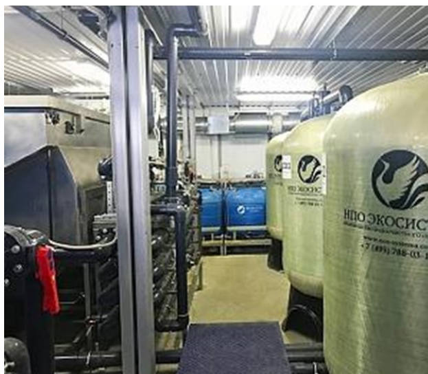
Рисунок 5.3-1. Очистные сооружения флотационной очистки промышленных сточных вод модель «Валдай-ФЛ-130»
