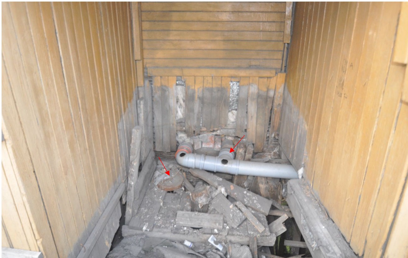
Фото 3. Разрушение инженерных систем теплоснабжения и системы водоотведения
