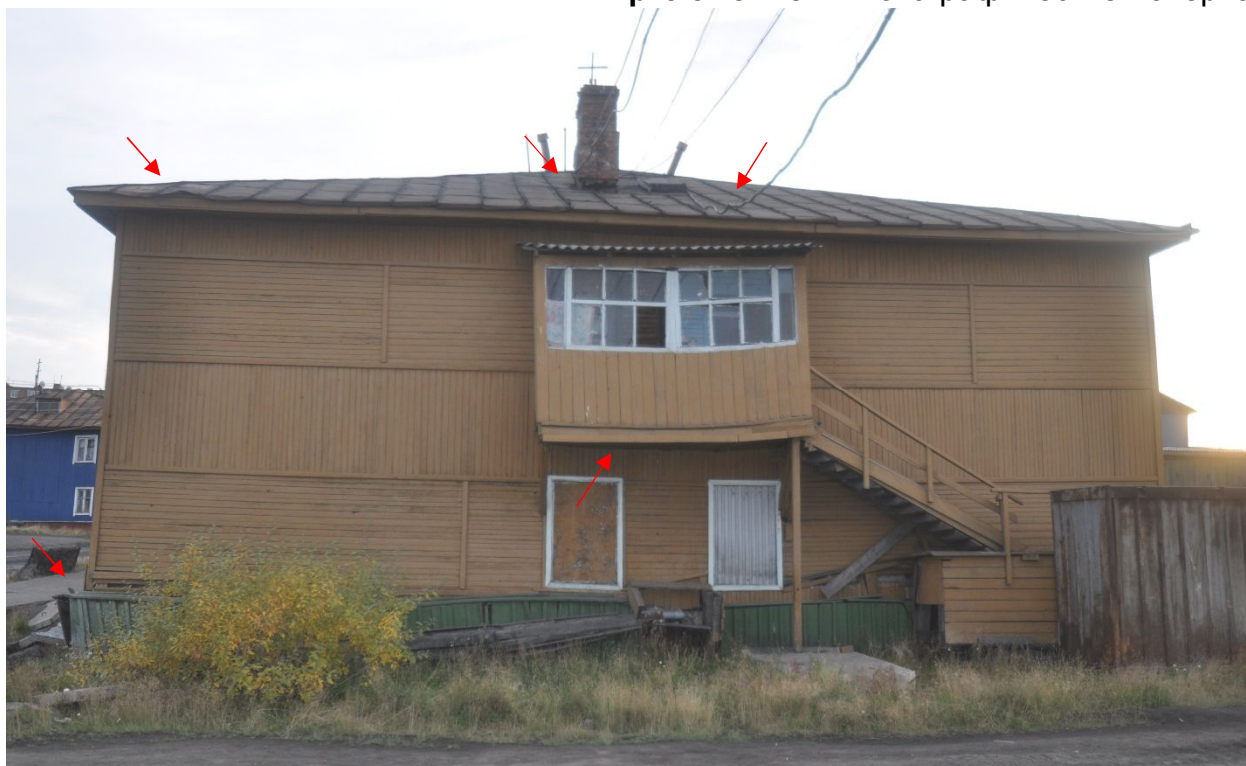
Фото 1. Деформация стен в горизонтальной плоскости, разрушение забирки, разрушение кровельного покрытия, прогибы балок балкона
