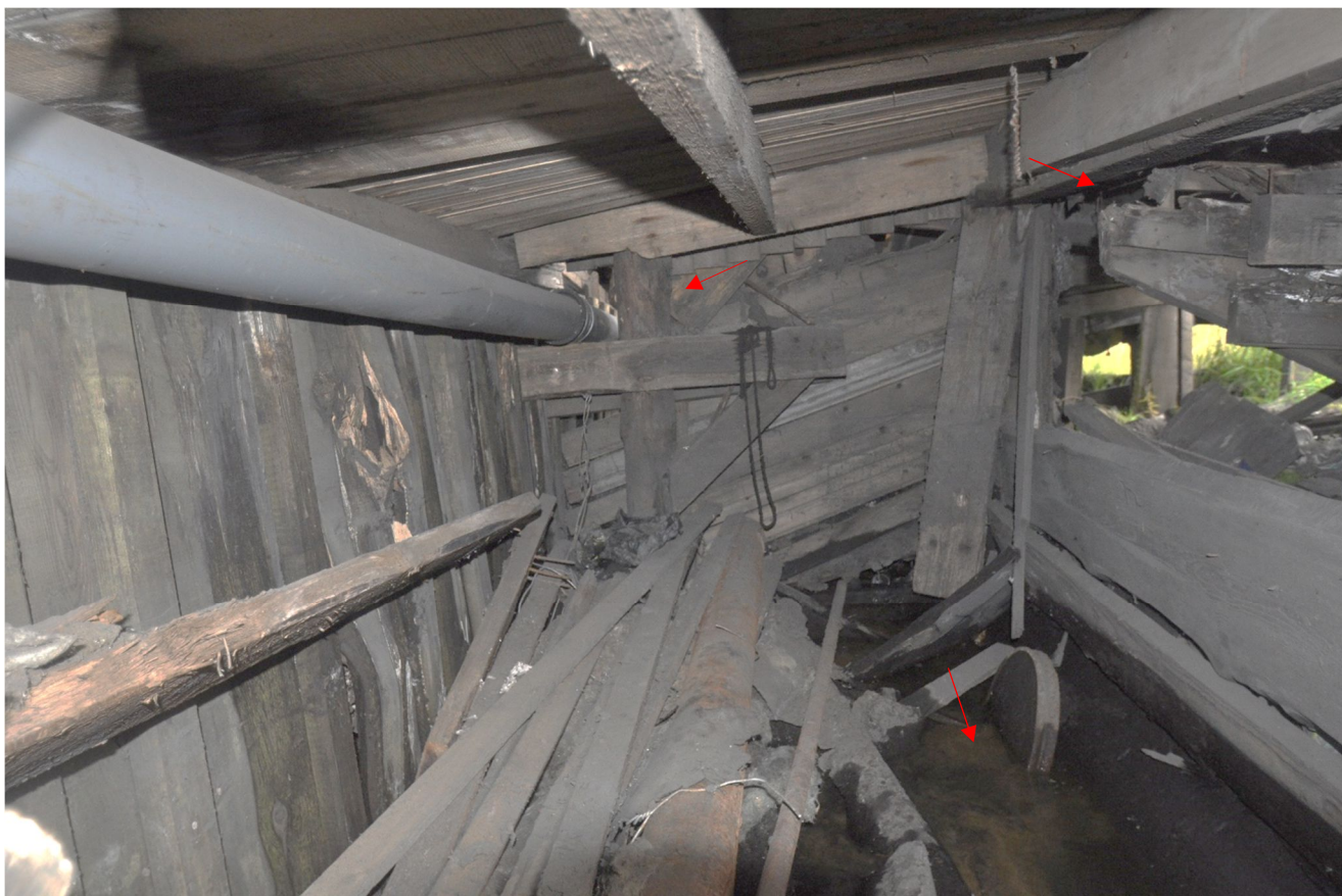
Фото 4. Разрушение свайного основания. Застаивание техногенных и грунтовых вод в техническом подполье
