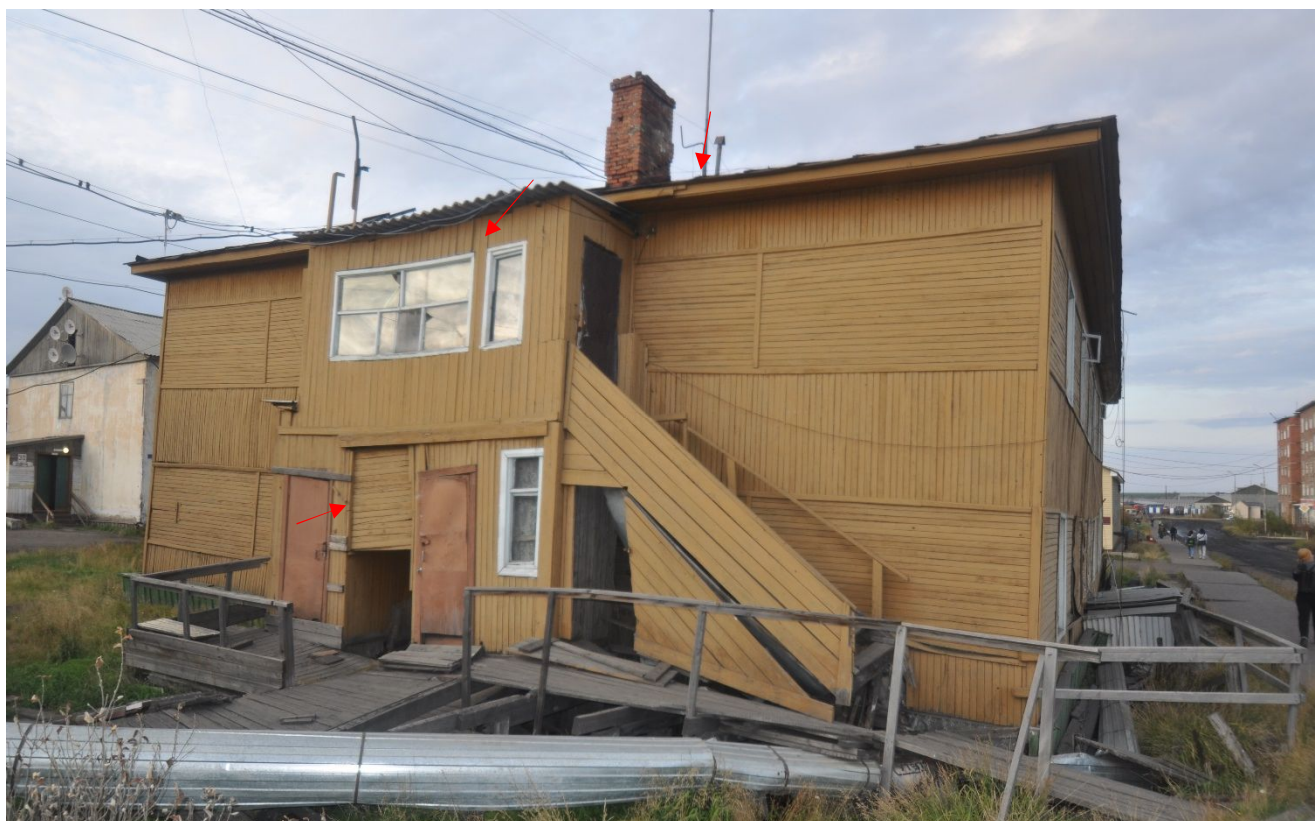
Фото 2. Деформация стен в горизонтальной плоскости, разрушение забирки, прогибы балок балкона
