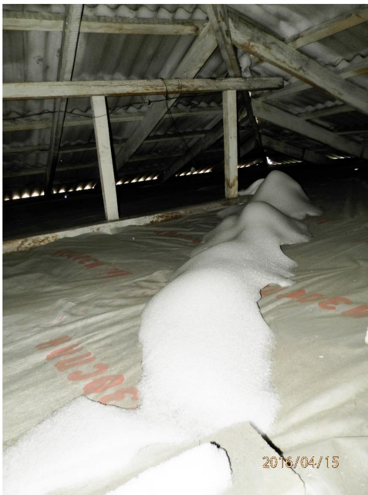
Фото 6 Задувание снега через конструкции соединения кровельного покрытия А-Б(1-2)
