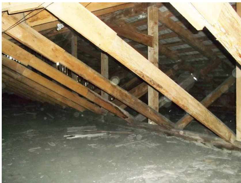
Фото 8 отсутствие огнезащитной обработки деревянных конструкций стропил (корпус 1)
