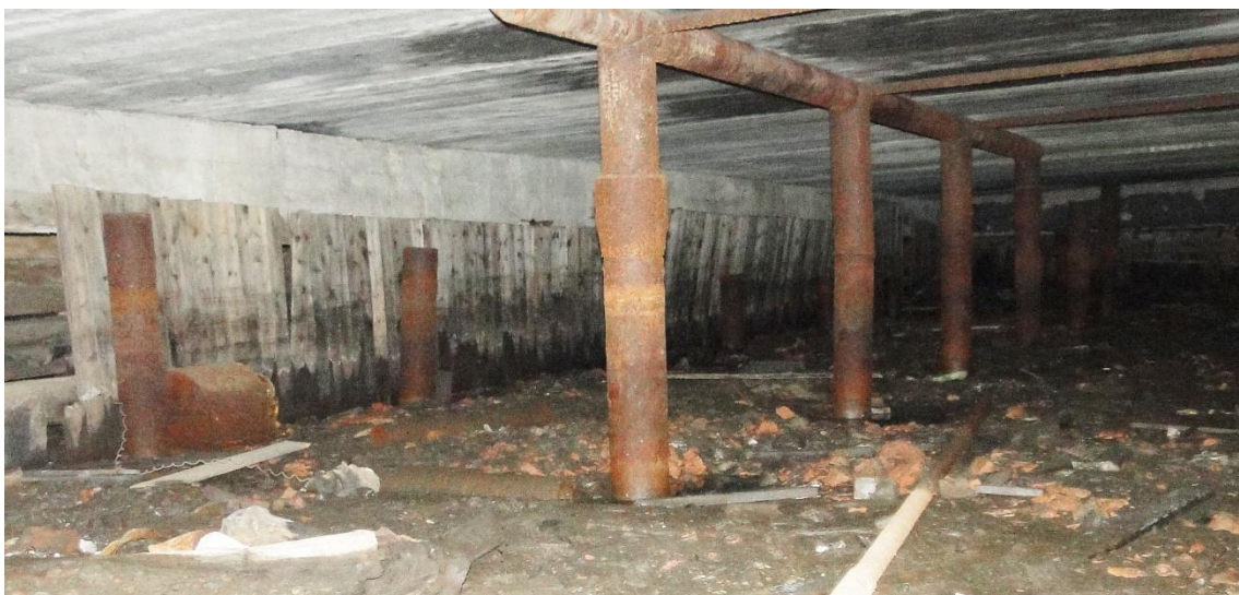
Фото 5 Коррозия свайных оголовков , увлажнение плит перекрытия ростверков , Г1-В1(10-11) корпус 1
